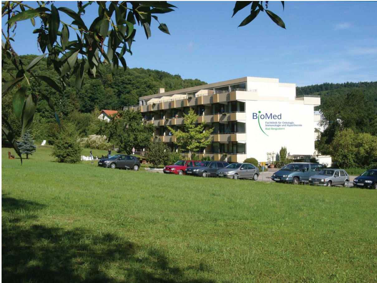
Blick auf Klinik-Gebäude Haus 8
