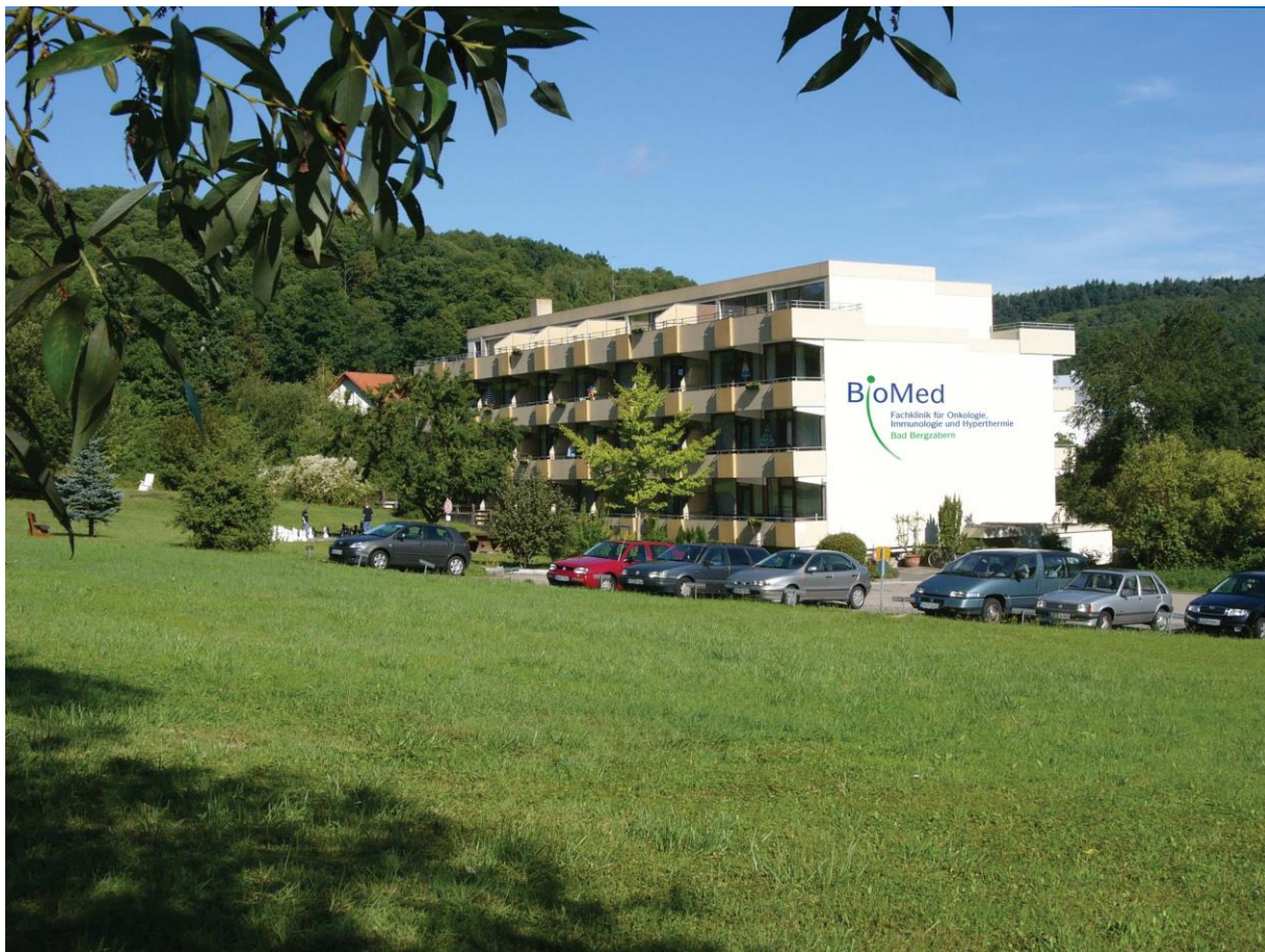
Blick auf Klinik-Gebäude Haus 8
