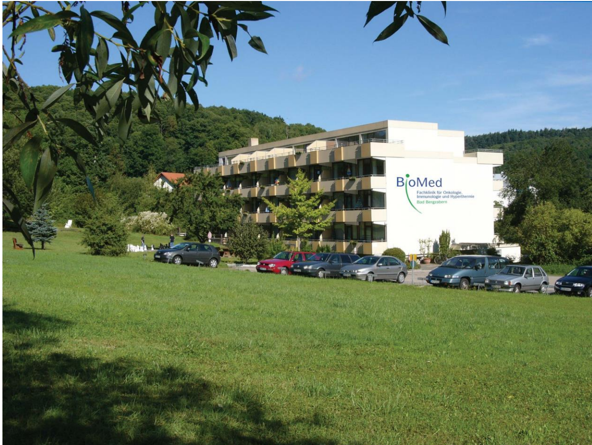
Blick auf Klinik-Gebäude Haus 8
